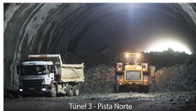
Túnel 3 - Pista Norte
